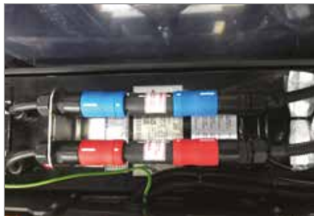
Batería Ex típica (Fíjese en la etiqueta con las especificaciones y la certificación en la tapa)
