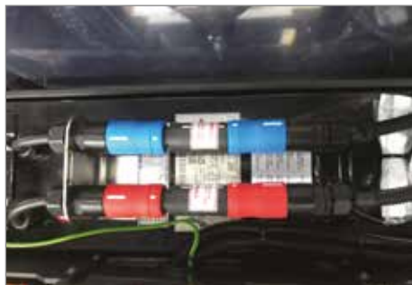
Batterie Ex e standard (notez l'étiquette d'identification et de certification sur le couvercle)
